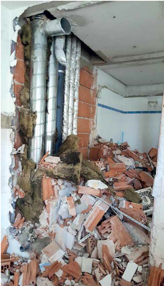
Bsp.: 5_Medienleitungen mit KMF isoliert
