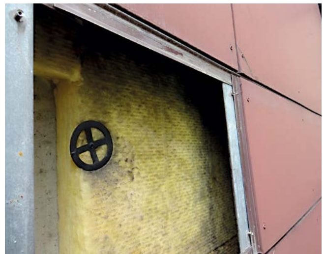
Bsp.: 3a_Außenfassade mit KMF-Dämmung
