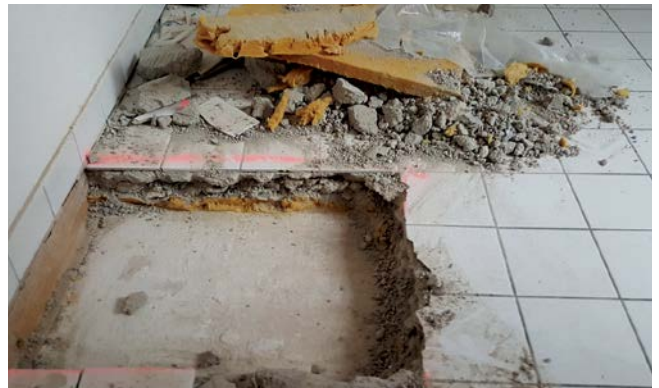
Bsp.: 4_Trittschalldämmung aus KMF
