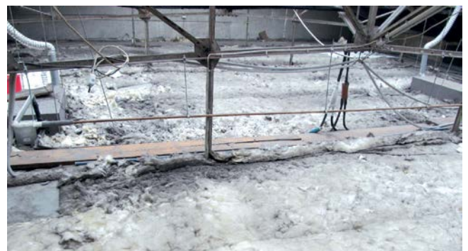
Bsp.: 6_Dachstuhl mit KMF ausgelegt
