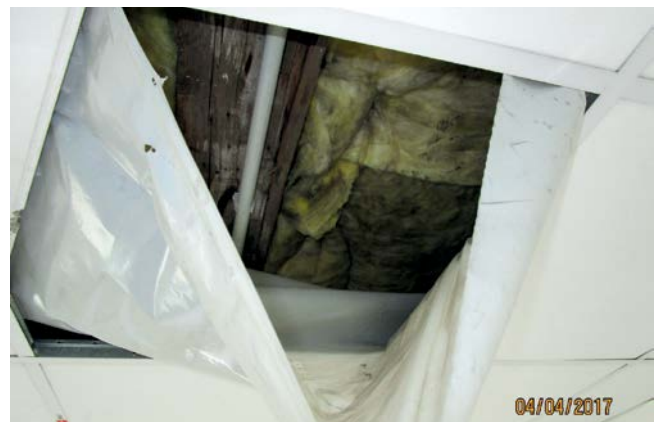
Bsp.: 8_KMF-Matten hinter abgehängter Decke
