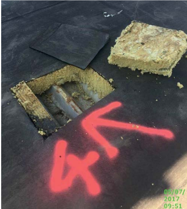
Bsp.: 3b_KMF-Dämmung unter bituminöser Abdeckung
